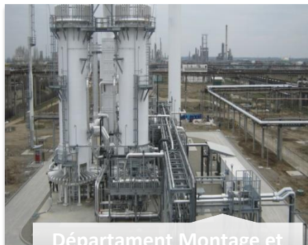
Département Montage et Réparation des installations industrielles
