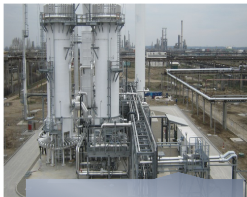
Departament Montaj & Reparații Instalații Industriale
