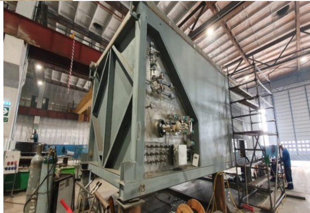
Constructions métalliques REKTI & HEX Box, projet Kedainiai Lituanie Client: Linde AG Période: Mars - Sept.2019
