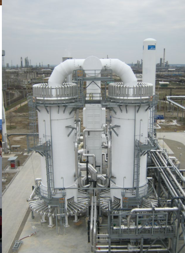
Fabrica de Separarea Aerului Linde Galați GOX 60000 Nmc Locație: ArcelorMittal Galați, Romania Perioada: 2011 - 2012 Scop: proiectare construcții industriale; execuție și montaj instalații (aprox. 400 to); montare echipamente de mare capacitate (cu macarale pe șenile de 700 to.); teste de presiune; lucrări electrice și de automatizări; punerea în funcțiune a echipamentelor și training personal.
