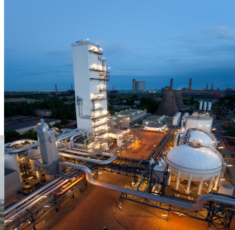
Fabrica de Separarea Aerului Linde Galați GOX 60000 Nmc Locație: ArcelorMittal Galați, Romania Perioada: 2011 - 2012 Scop: proiectare construcții industriale; execuție și montaj instalații (aprox. 400 to); montare echipamente de mare capacitate (cu macarale pe șenile de 700 to.); teste de presiune; lucrări electrice și de automatizări; punerea în funcțiune a echipamentelor și training personal.
