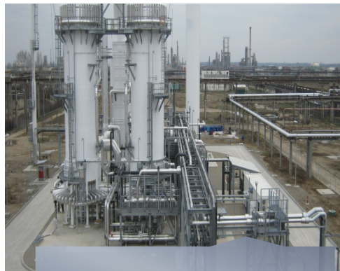
Departament Montaj & Reparații Instalații Industriale
