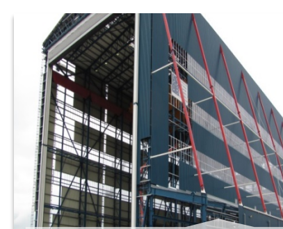
Département Génie Civil
