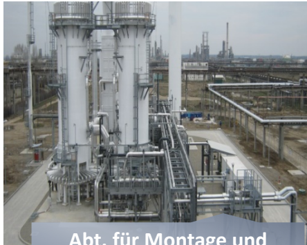
Abt. für Montage und Reparatur von Industrieanlagen
