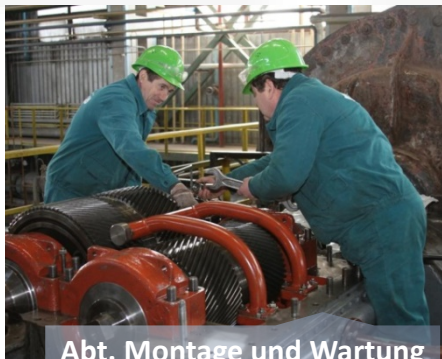
Abt. Montage und Wartung von dynamischen Ausrüstungen
