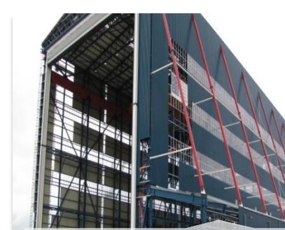
Département Génie Civil
