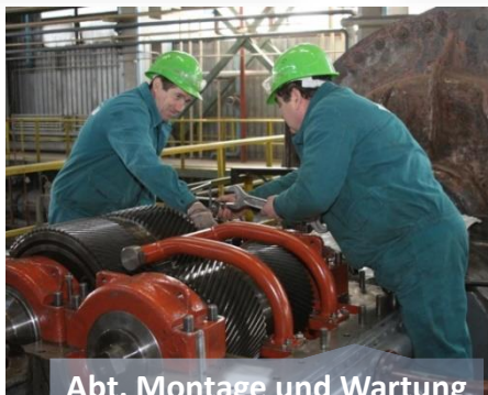
Abt. Montage und Wartung von dynamischen Ausrüstungen
