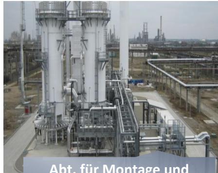
Abt. für Montage und Reparatur von Industrieanlagen
